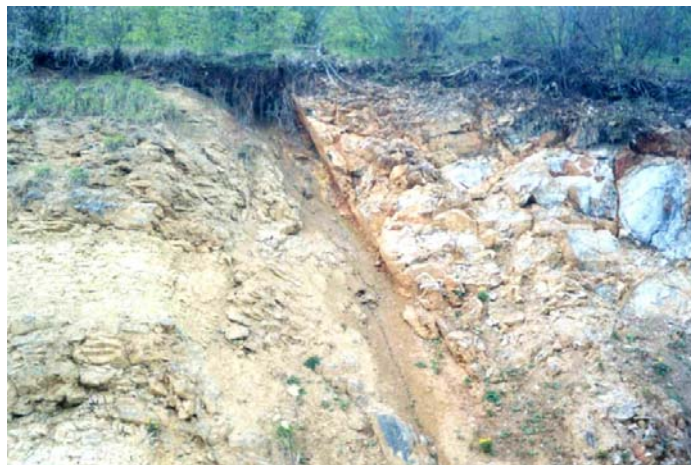
Slika 14 – Rasjed između anizijskih i ladinskih naslaga u usjeku puta za Bjelašnica
