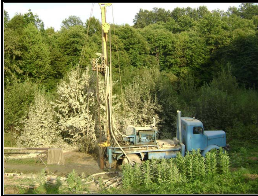
Slika 8. Izvođenje istražne bušotine na lokalitetu Vranovac (foto M.Lazić, 2008.)
