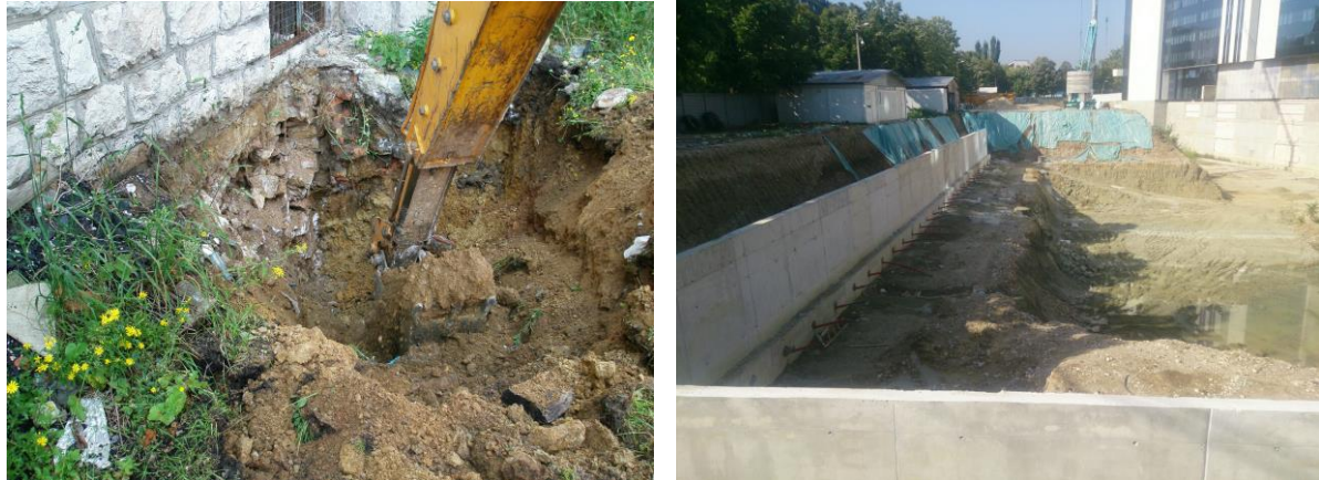
Slika 7. Određivanje D_f već postojećeg objekta (lijevo) i temeljna jama pored izgrađenog objekta (desno)
