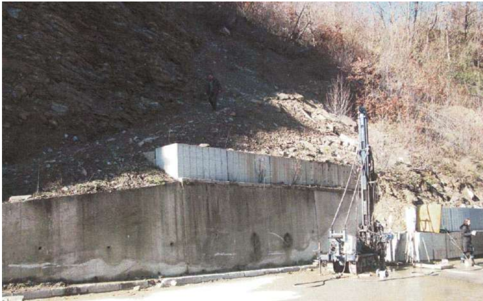
Slika 5. Bušenje geomehničke bušotine u nožičnom dijelu klizišta
