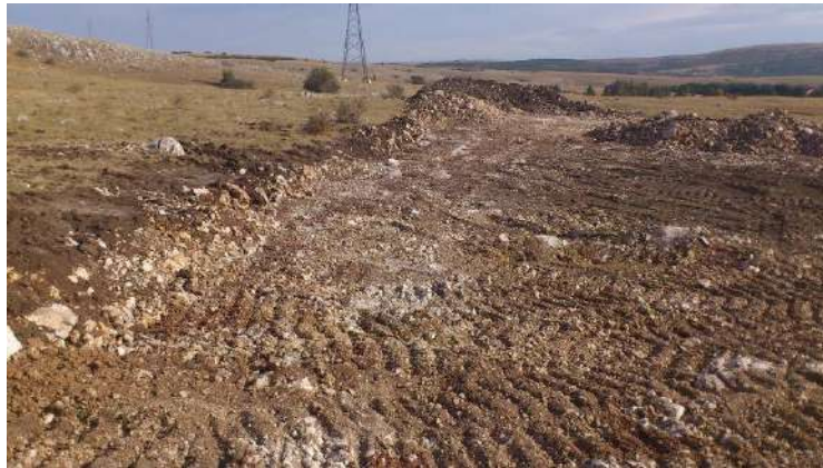
Slika 18. Lokaciju izgradnje većeg platoa na kojem se postavlja trafostanica
