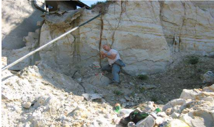
Slika 12. Mjerenje orijentacije pukotina u čeonom dijelu klizišta (Foto: A. Čomić, 2011.)
