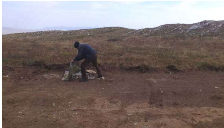
Slika 5. Glinovito - kameniti pokrivač u zoni vrtače, koji nisu povoljni za temeljenje vjetroagregata
