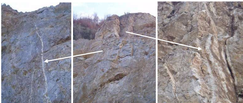
SI 3. Lijevim horizontalnim kretanjem duž rasjeda 307/87 formirane su tenziona pukotine 241/81
