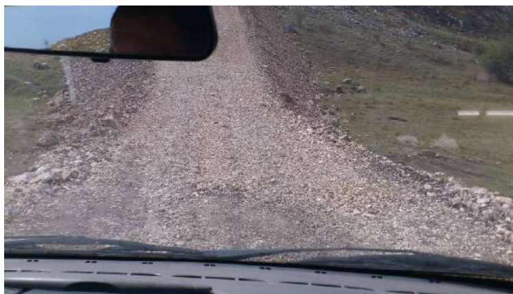
Slika 16. Primjer “prelaska“ pristupnog puta preko veće vrtače sa debljim pokrivačem ( pripremni radovi )
