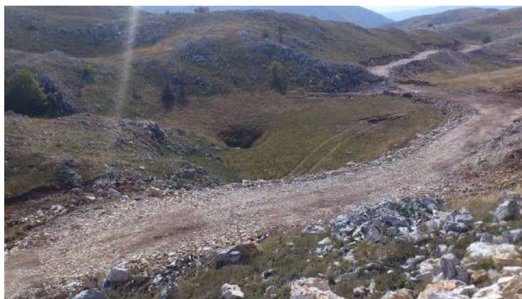
Slika 17. Pogled na dio kružnog servisnog puta u zoni izgradnje vjetroagregata
