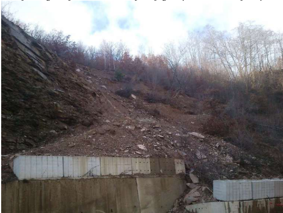
Slika 1. Panoramska slika klizišta sa jasno vidljivim potpornim konstrukcijama (AB zid i gabioni)
