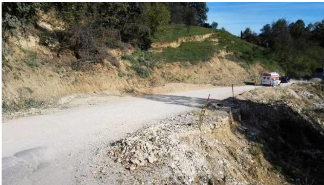
Slika 7. Izmještena trasa ceste izgrađena od nasutog materijala sa jasno izraženim elementima klizanja iznad trase.
