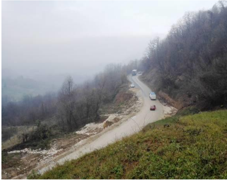
Slika 8. Panoramski pogled na blatni tok ispod novoformirane trase ceste.
