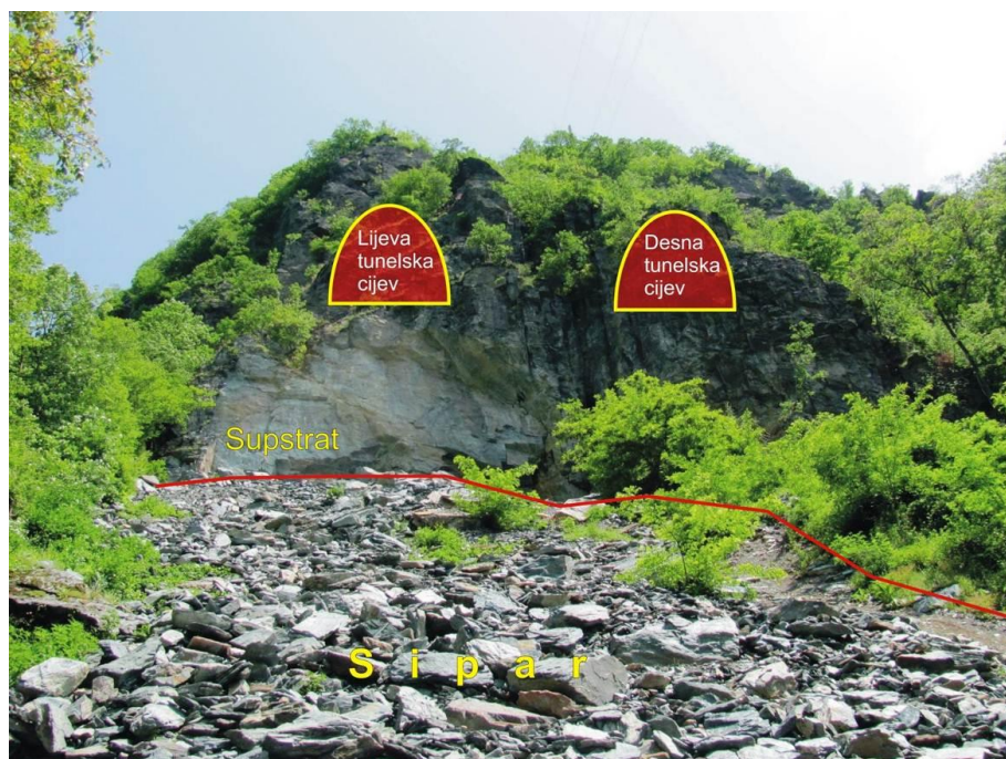
Slika 5 – Tehnogene tvorevine - sipar, supstrat, te orjentacioni položaj izlaznog portala tunela III.
