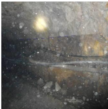
Слика 10. Линија воденог огледала до које је била потопљена јама
