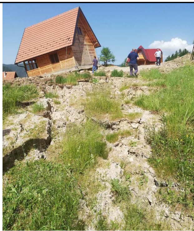
Slika 9 Pokrenuti montažni objekti, plitko fundirani na tlu sa kojeg su skinuti četinari - trbuh klizišta „Mandići” - 13.6.2019. g.
