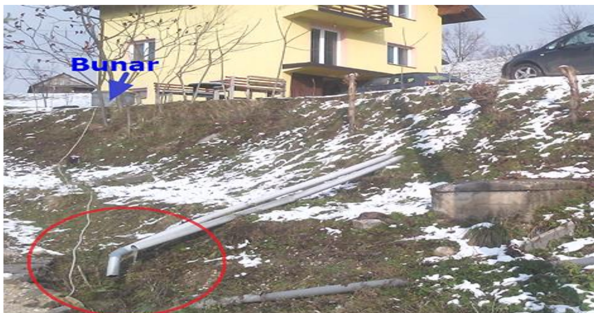
Slika 8. Prikaz neadekvatnog tretmana otpadnih voda iz domaćinstava i izvedenih preliva iz bunara. (Foto J.Čomić, januar 2018 godine).
