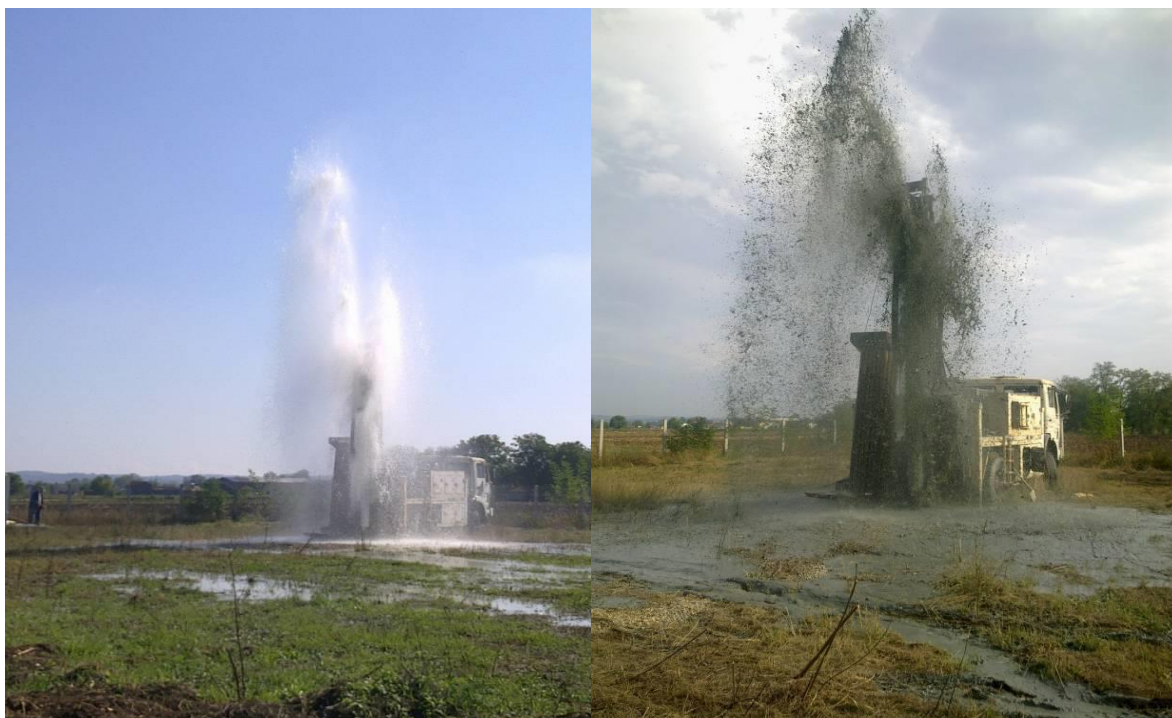
Slika 7. Izrada Bunara IEB-1 na izvorištu u Maglajanima za vodosnabdijevanje Laktaša
